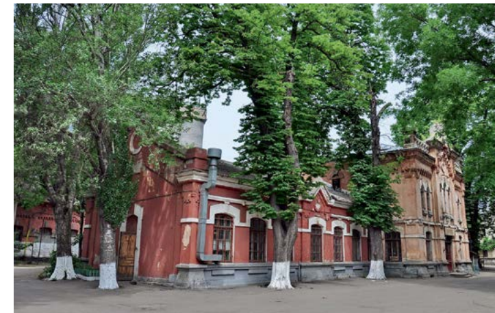
Одесская водонасосная станция главная (Чумка). Водопроводная ул., 15
