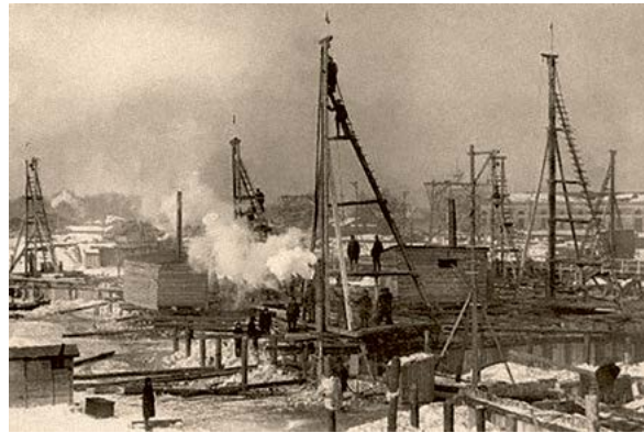
Строительство Троицкого Моста
